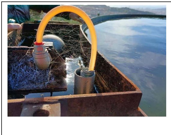
Imatge 23: Exemple del sistema d'abastiment automàtic amb boia de control i punt de captació al camí d'accés als camps
